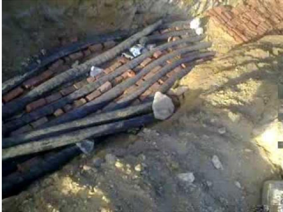
شكل -13- الدفن المباشر للقابلو الكهربائي تحت الارض
