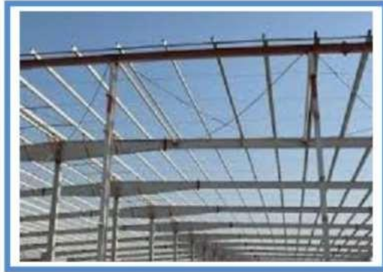
الصورة رقم (2) توضح الابنية ذات الهيكل المعدني.
