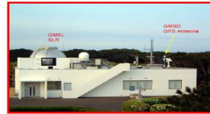
محطة المراقبة في كلورادو
