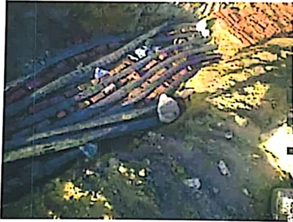
شكل -13- الدفن المباشر للقابلو الكهربائي تحت الارض
