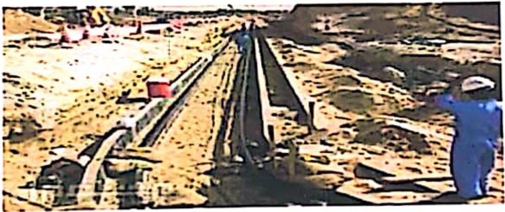
شكل -15- حفر القنوات الارضية لمد قابلو ارضي
